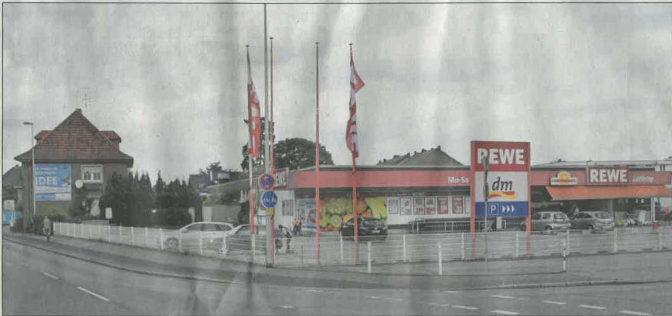
• Das Gelände, auf dem der REWE-Markt Lütfring steht, wird schon bald zur Großbaustelle.
