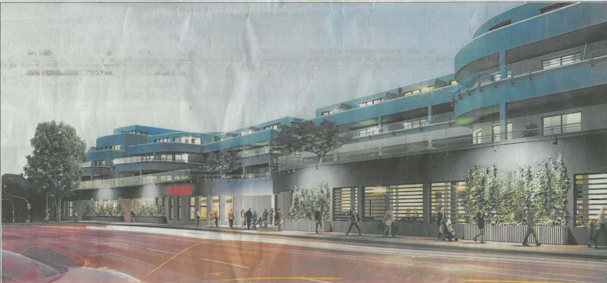
• Blick bei Abenddämmerung auf den neuen Komplex „Ostwall-Terrassen“, der Mitte 2020 fertiggestellt sein soll.
